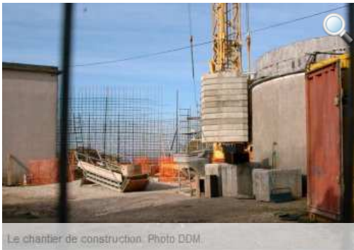
Le chantier de construction. Photo BDM.
