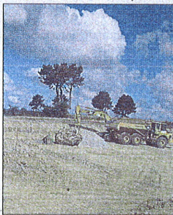
Une belle plateforme pour implanter un nouveau réservoir.
